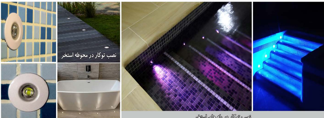
نصب توکار در پله های استخر
