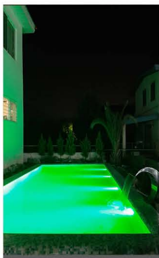
نصب توکار در دیواره استخر بوسیله قاب بتونی
