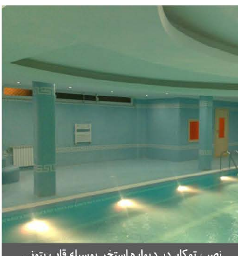
نصب توکار در دیواره استخر بوسیله قاب بتونی
