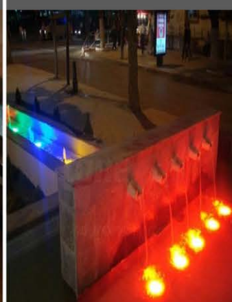
نصب در کف آبنما بصورت روکار
