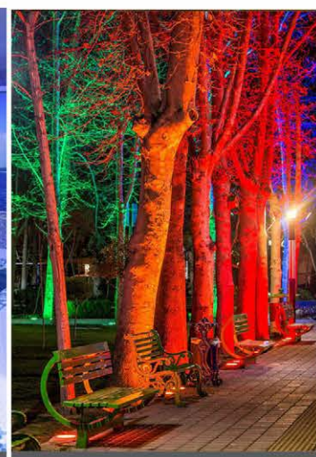
نصب بصورت دفنی در فضای سبز و محوطه سازی
