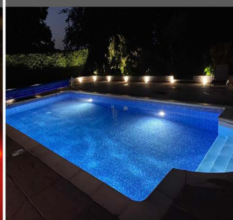
نصب در دیواره استخر بصورت روکار
