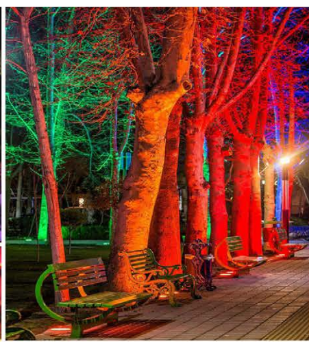
نصب بصورت دفنی در فضای سبز و محوطه سازی
