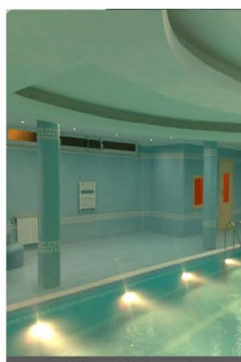
نصب توکار در دیواره استخر بوسیله قاب بتونی
