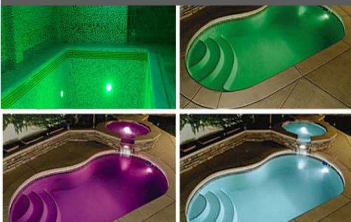
نصب در دیواره استخر بصورت روکار
